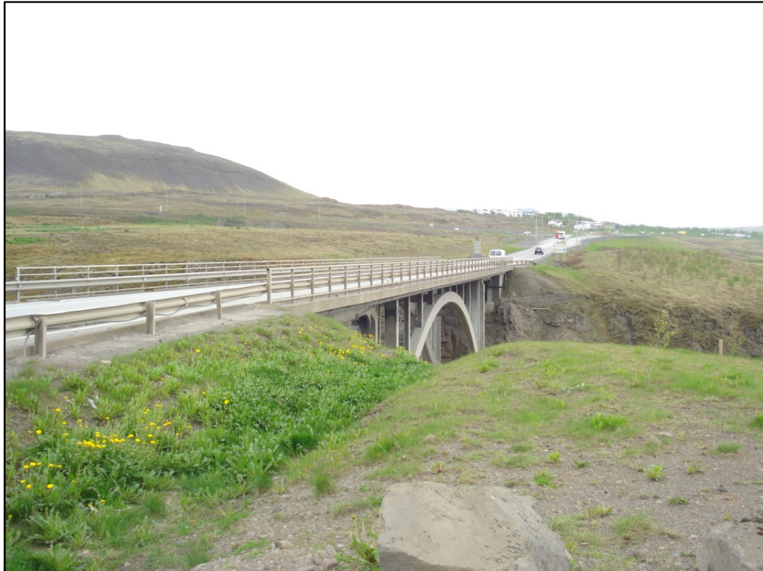
Mynd 2. Kaldakvísl, en malbikað var beint á steyppt brúargólfið. Sýni voru tekin úr gólfinu árið 2003 og 2008.
